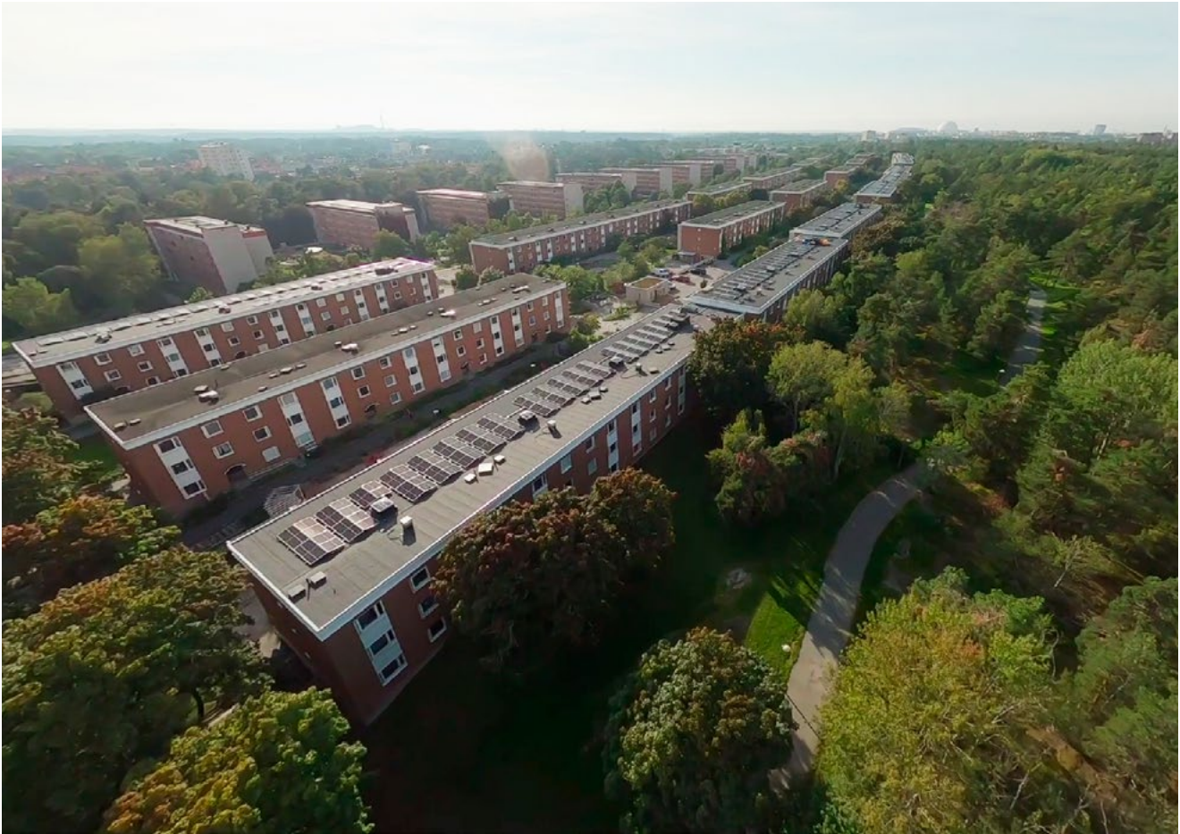
På 28 tak i Bagarmossen anlägger Stockholmshem Stockholms största solcellspark. Under 2023 blev första etappen klar. När hela anläggningen på 5 500 m 2 solceller är i drift kommer den producera 900 megawattimmar el årligen. Flygfoto: Tomi Heder.
