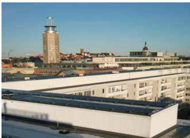
En solcellsanläggning som blev klar 2021: 1 600 kvadratmeter på kvarteret Linjalen, mitt på Södermalm. Foto: Bengt Alm.
