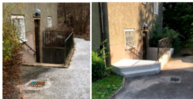
Före och efter: förhöjning runt källartrappa i Hökarängen. Foto: Stockholmshem
